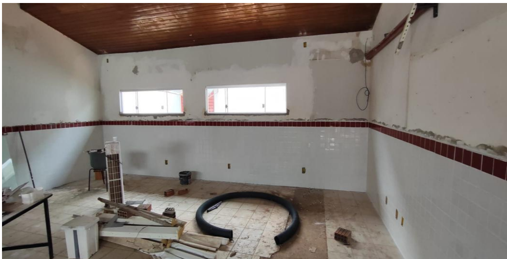
Figura 69 Reforma do Campus Xapuri 2 (Fonte: PROAD)
