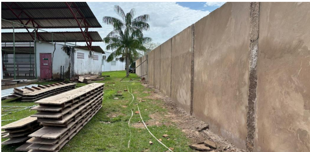
Figura 68 Reforma do Campus Xapuri 1 (Fonte: PROAD)
