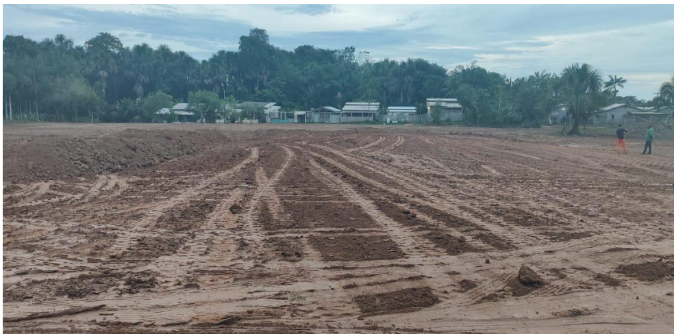
Figura 72 Início dos trabalhos do Campus Feijó 2 (Fonte: PROAD)
