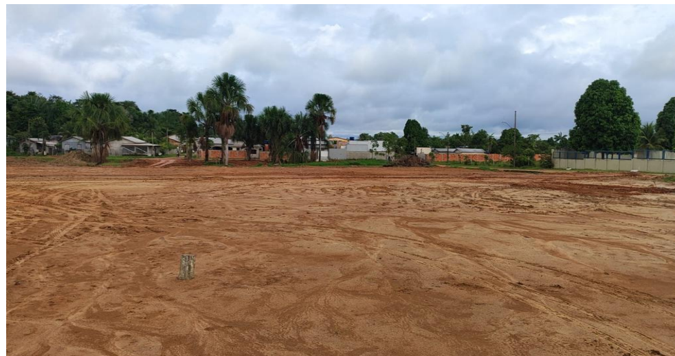
Figura 71 Início dos trabalhos do Campus Feijó 1 (Fonte: PROAD)
