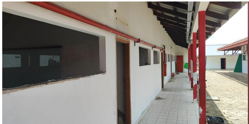
Figura 70 Reforma do Campus Xapuri 3 (Fonte: PROAD)
