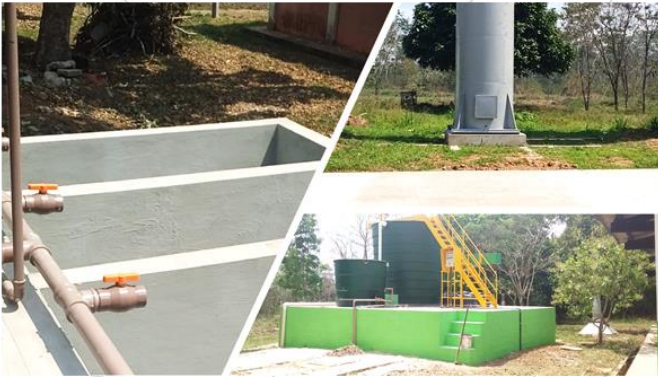
Terceira fase da reforma do Campus Rio Branco Baixada do Sol (Sistema de água e esgoto)
