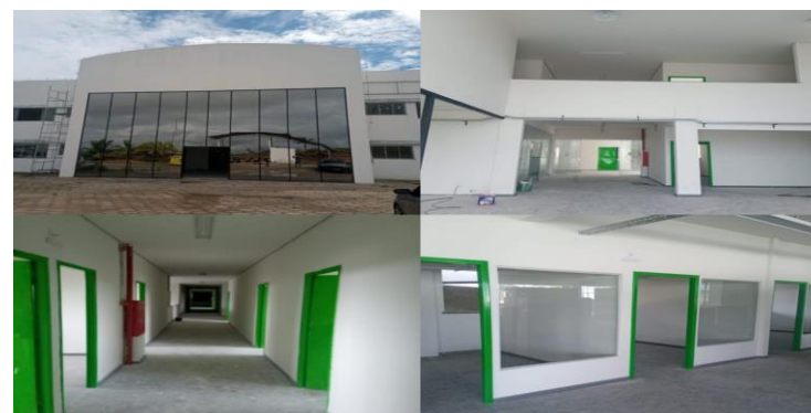
Figura 16: Reforma e Ampliação do Campus Cruzeiro do Sul (em execução)
