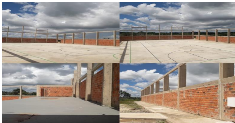
FIGURA 13: CONSTRUÇÃO DA QUADRA POLIESPORTIVA DO CAMPUS TARAUACÁ - 1ª FASE (CONCLUÍDA)
