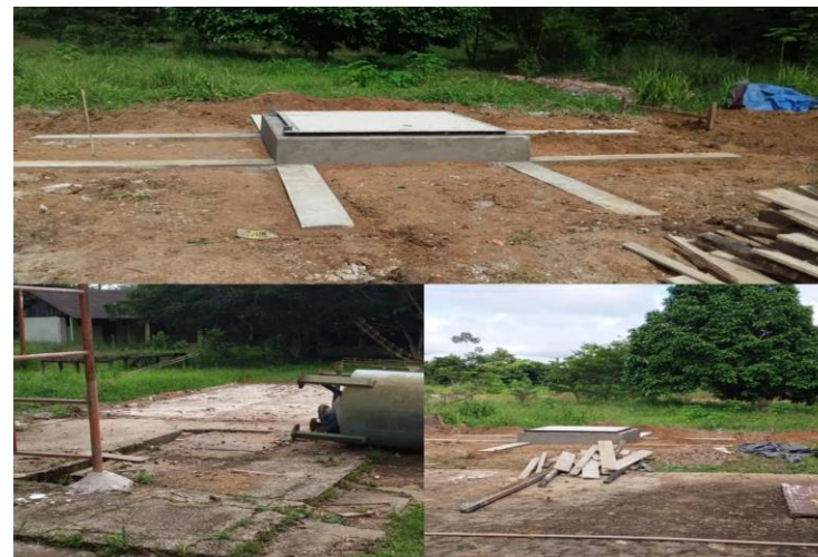
FIGURA 15: 3ª FASE (SISTEMA DE ÁGUA E ESGOTO) – EM EXECUÇÃO
