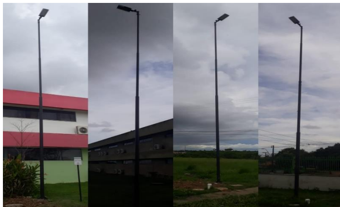
FIGURA 22: ADEQUAÇÃO NAS LUMINÁRIAS EXTERNAS DO CAMPUS RIO BRANCO (EM EXECUÇÃO)
