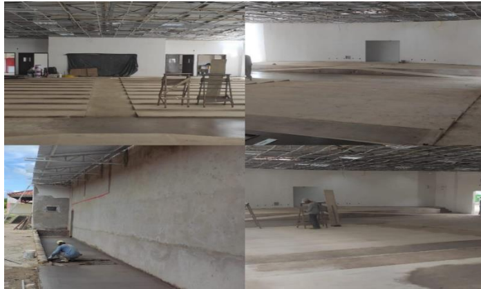
FIGURA 21: REFORMA DO AUDITÓRIO DO CAMPUS XAPURI (EM EXECUÇÃO)
