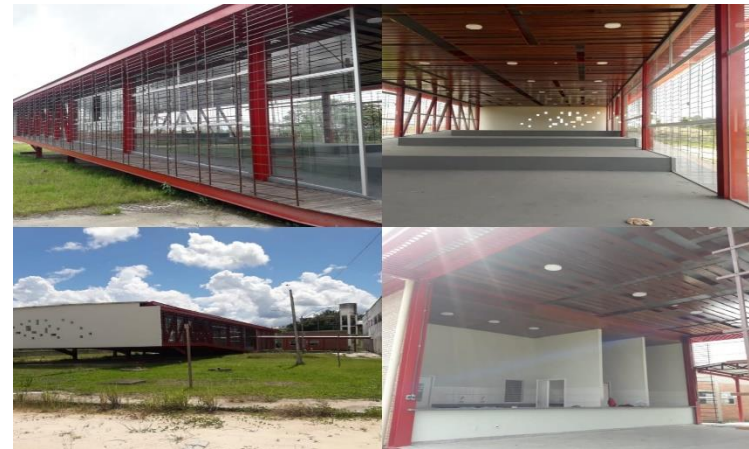
FIGURA 23: CONSTRUÇÃO DO REFEITÓRIO, COZINHA E ÁREA DE CONVIVÊNCIA DO CAMPUS TARAUCÁ
